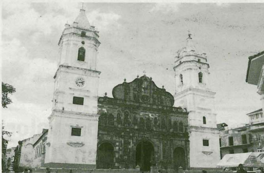
Vista de la fachada de la catedral de Santa María de Panamá, en la que trabaja la firma navarra.
